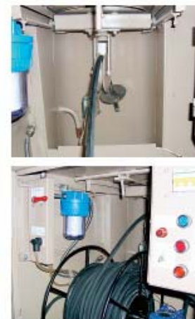
Рис. 7.8. Устройство очистки, промывки и дезинфекции внутренней поверхности ствола мусоропровода
