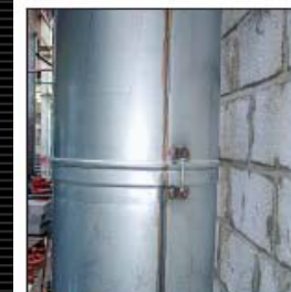
Рис. 7.2. Ствол мусоропровода со сварочным швом и болтовым соединением секций
