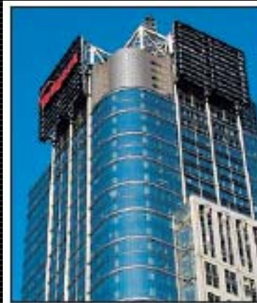
Рис. 15. Верхние этажи здания «Four Times Square» с интегрированными фотоэлектрическими панелями
