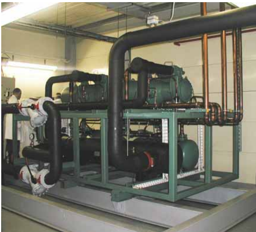
Производимый компанией «Термокул» типовой чиллер для систем кондиционирования на базе 2х спиральных компрессоров Битцер ESH736.
